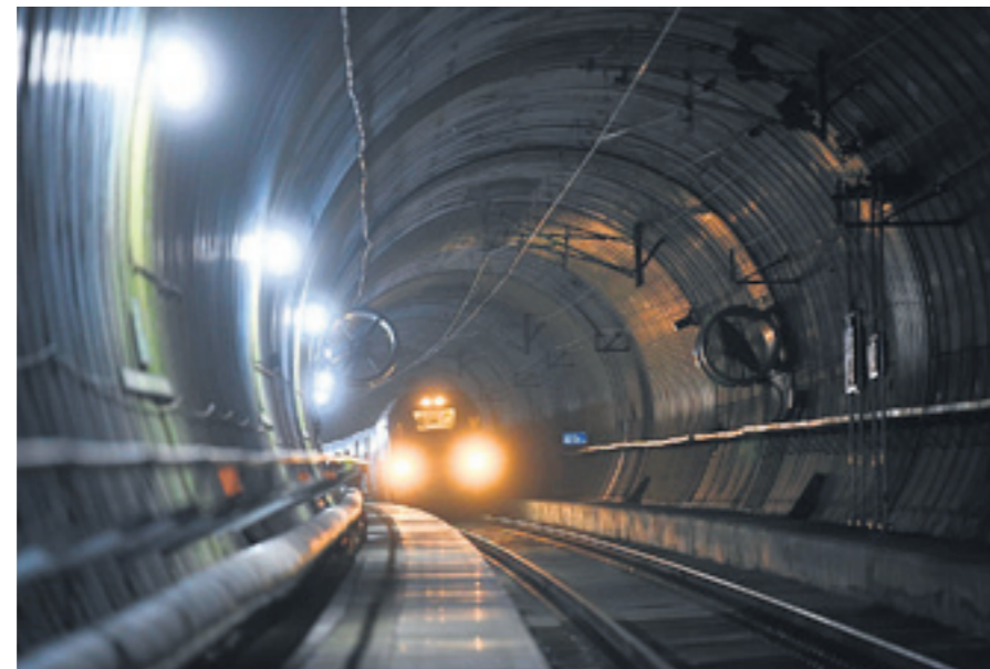
Interior de uno de los túneles de Pajares
